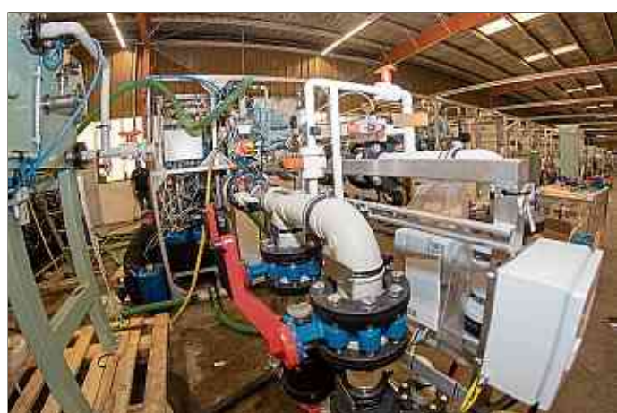
Parallel werden in der Halle mehrere Filter für verschiedene Schiffe gebaut.
