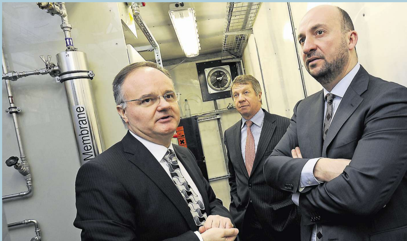
CEO Bogdan Serban (l.) gab Wirtschaftsminister Schneider (r.) die nötigen Erläuterungen zur Anlage
